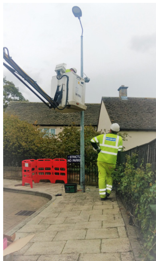
Installation des stations EcomSmart par SSE
