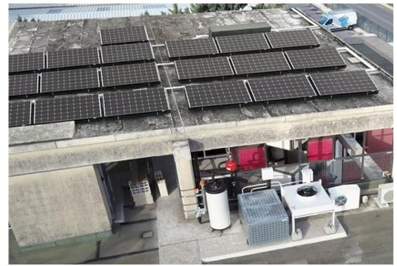
Prototype PV-COOLING: (climatisation solaire)
