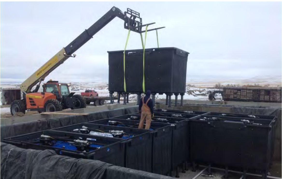
Installation d'un MyFAST® pendant une construction dans le Dakota du Nord
