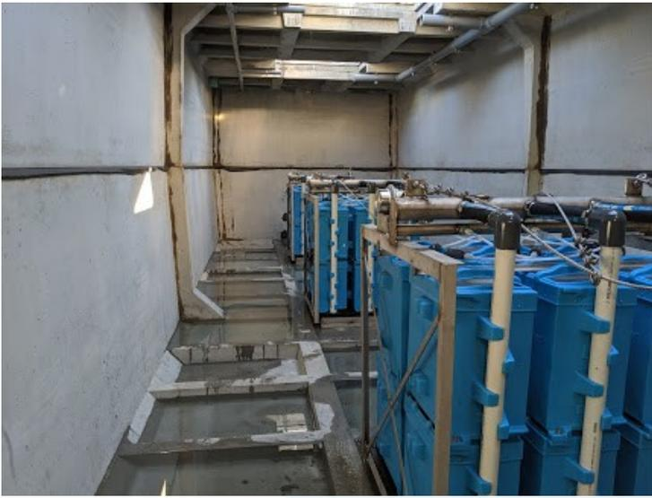
Afin d'assurer une qualité constante des effluents, le système (une version optimisée de notre système certifié NSF/ANSI 350, classe R pour la réutilisation de l'eau pour le traitement total des eaux noires et des eaux grises) répond à des directives strictes en matière de qualité de l'eau offrant davantage de possibilités de recyclage de l'eau.
